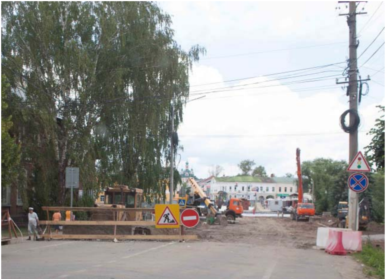
Дорога перекрыта, идут ремонтные работы. Сквозного проезда через город нет.
